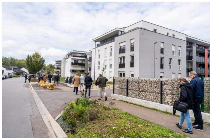
La résidence de 107 logements neufs de Batigère a été livrée en juillet 2023, rue du Château-de-Merten, à Amnéville. Inaugurée ce vendredi 4 octobre, elle est présentée par le bailleur social comme « une opération emblématique » pour la commune. Photo Hugo Azmani
